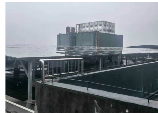
湘窖光伏建設
