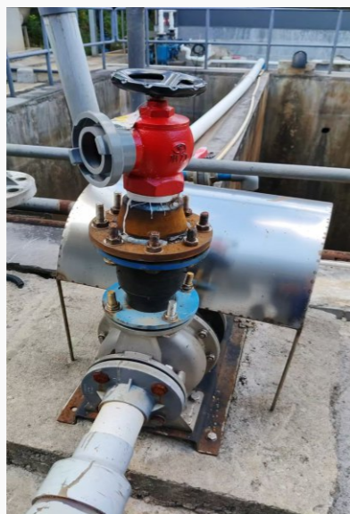
污水處理站中水利用於綠化澆水
