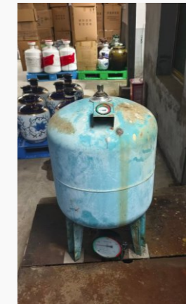
釀酒車間水井維修
