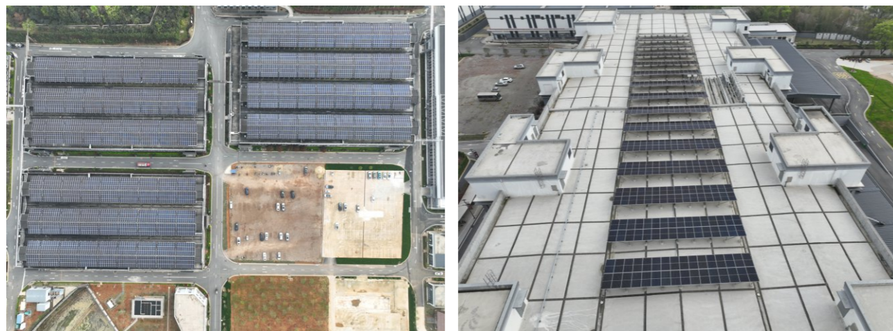
李渡光伏建設
