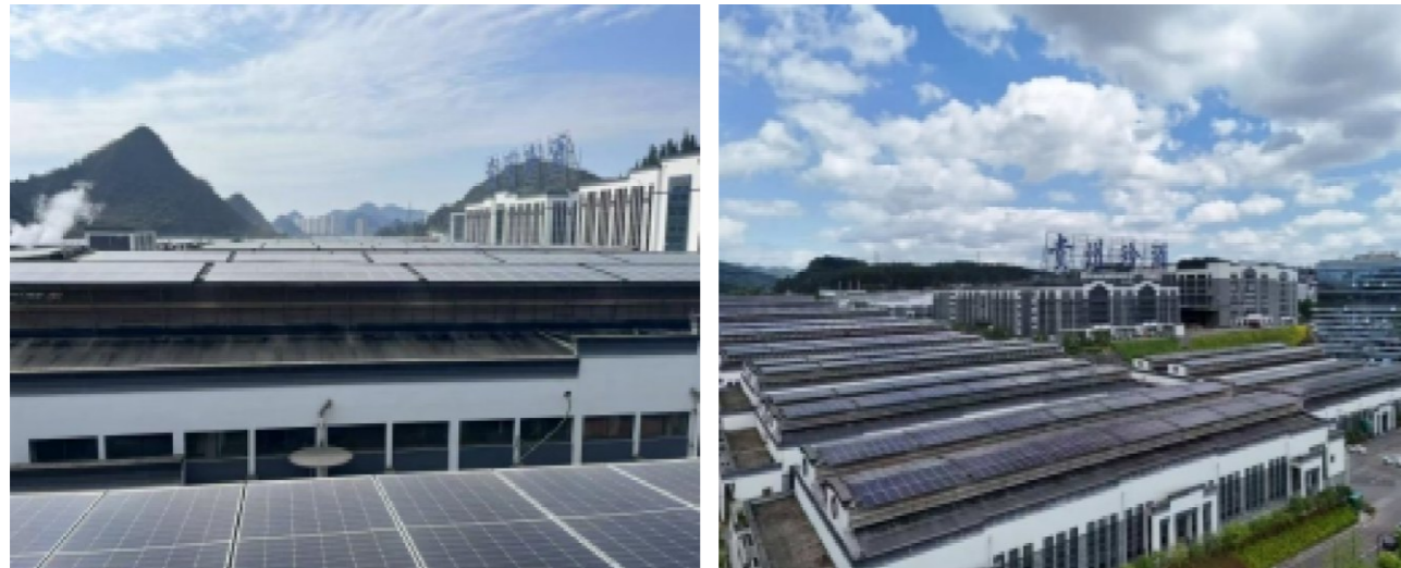
珍酒光伏建設
