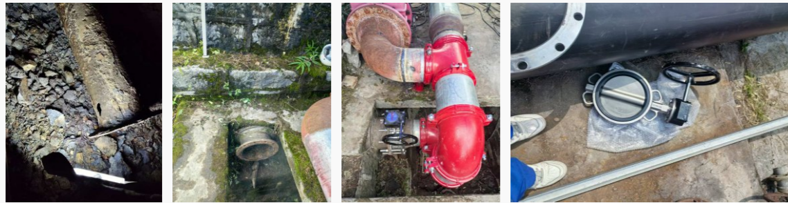
十字鋪廠區高位水池管道、閥門整改
