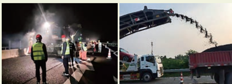
應用 NovaChip 超薄磨耗層罩面施工技術，降低路面破損率
