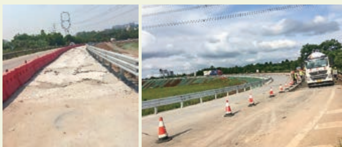
開展互通擴容改造技術課題研究，提升道路建設質量
