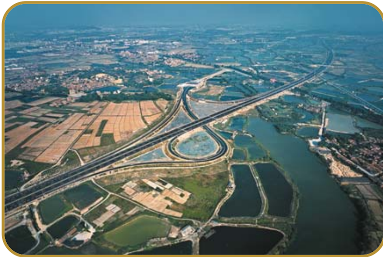
西二環高速公路
