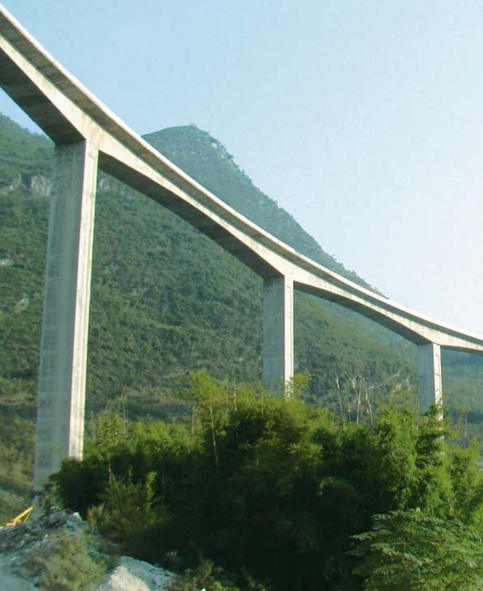
清連高速公路（在建） 一杜步三號橋
