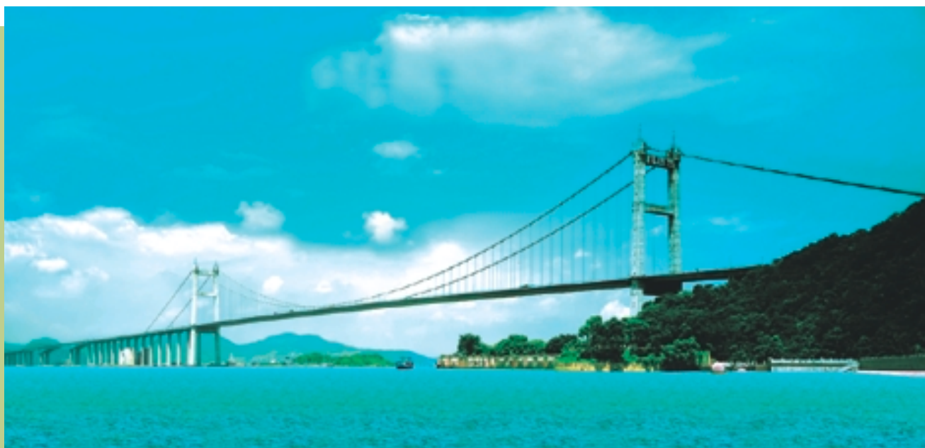
連接珠江三角洲東西岸的虎門大橋
