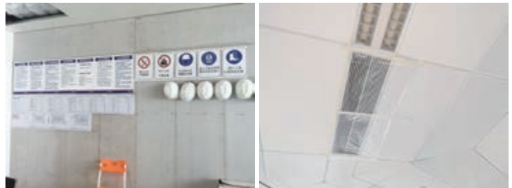
施工管理現場 粉塵控制(風口保護)
