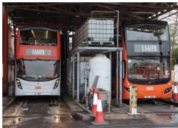
▲ 龍運於小蠔灣車廠引入雨水收集系統，配合水循環系統，進一步減少車廠耗水量
