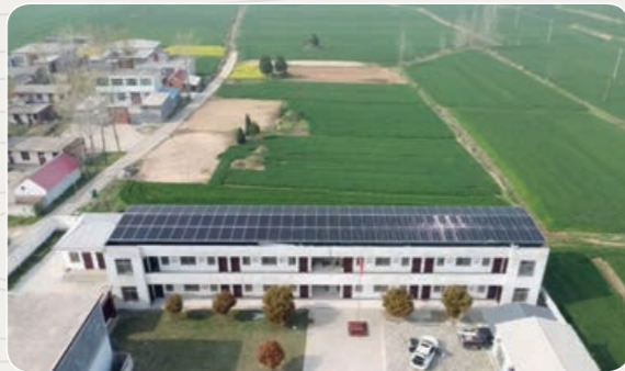
▲ 公共屋頂—河南村委會76kW電站
