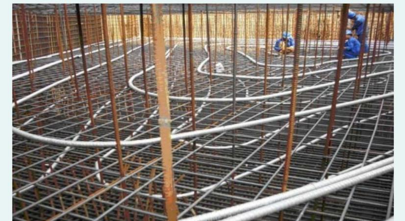
采用核心筒大体积混凝土裂缝控制技术进行水资源循环利用
