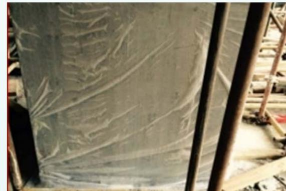
采用混凝土薄膜养护技术
