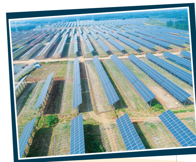
山東省新泰市集中式光伏發電站
