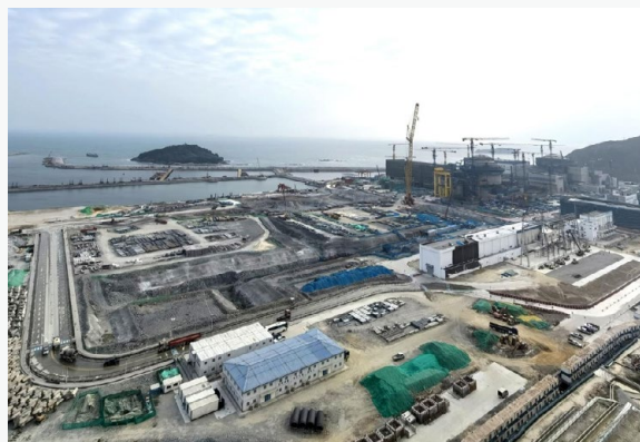
▶ 惠州太平嶺核電站 3、4 號機組（建設中）
