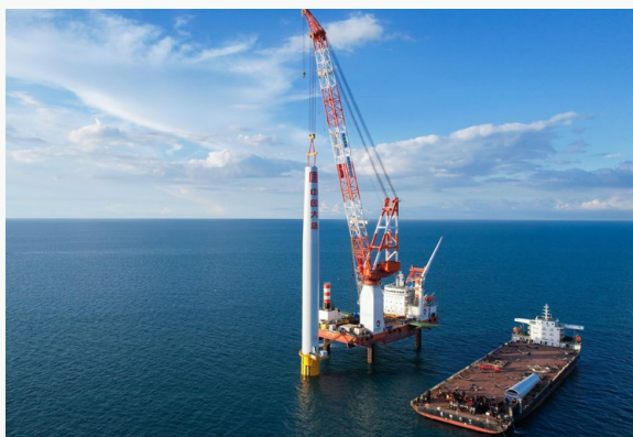
▶ 風電安裝船在進行風機吊裝
