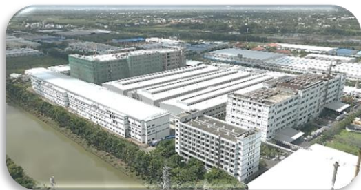
面料設施航拍圖
