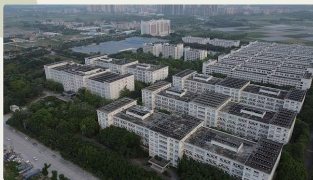
惠州廠房太陽能發電設施二期
