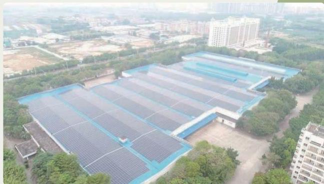
惠州廠房太陽能發電設施一期
