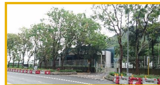
東涌牽引配電站
