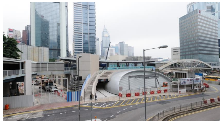
沙中綫於金鐘站的出入口
