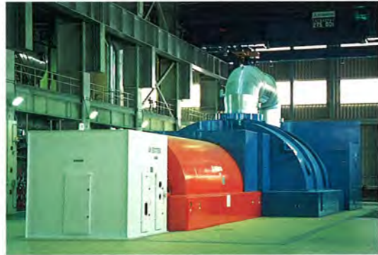
南丫島電廠第八組 350 兆瓦燃煤發電機組於一九九七年十二月啟用，到此電廠第三期發展工程已全部完成，電廠總安裝容量增至 3,305 兆瓦。
