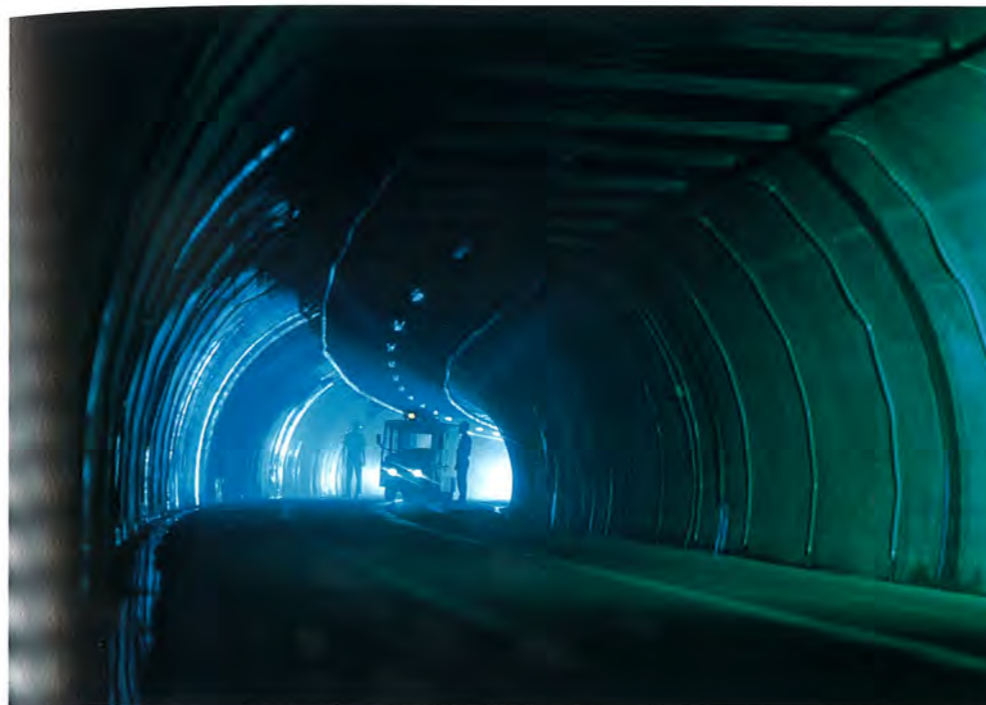
南風至柏架電纜隧道為港燈集團輸電系統的第二條電纜隧道，全長五點七公里。
