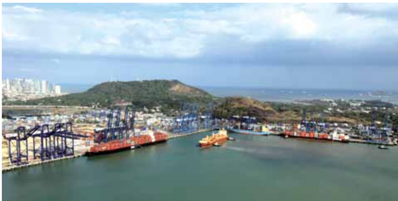
■ 巴拿馬港口公司旗下的巴爾博亞港正進行大規模擴建工程，四台超級超巴拿馬型岸邊吊機已率先運抵。
