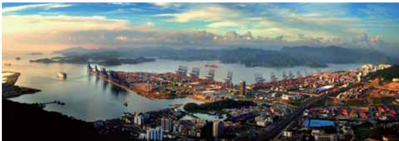
鹽田國際貨櫃碼頭第五個泊位擴建工程完成後，碼頭共有十五個深水貨櫃泊位。
