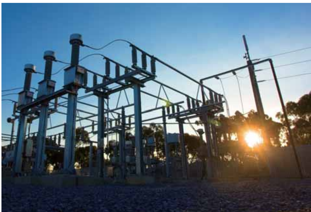
ETSA Utilities是南澳洲省的主要配電商，於該省從事興建、擴展、保養及提升配電網絡之工作。
