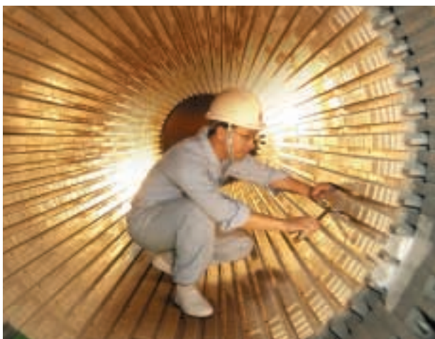
■ 港燈的技術員進行的渦輪發電機定期檢查，是預防性保養工作之一。一絲不苟的態度正是港燈保持百分之九十九點九九九供電可靠度的驕人紀錄的關鍵。
