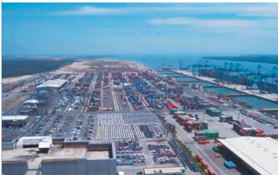
馬來西亞巴生西港配備先進設備，可以處理貨櫃、散裝乾貨、散裝液體貨物以及傳統貨物。
