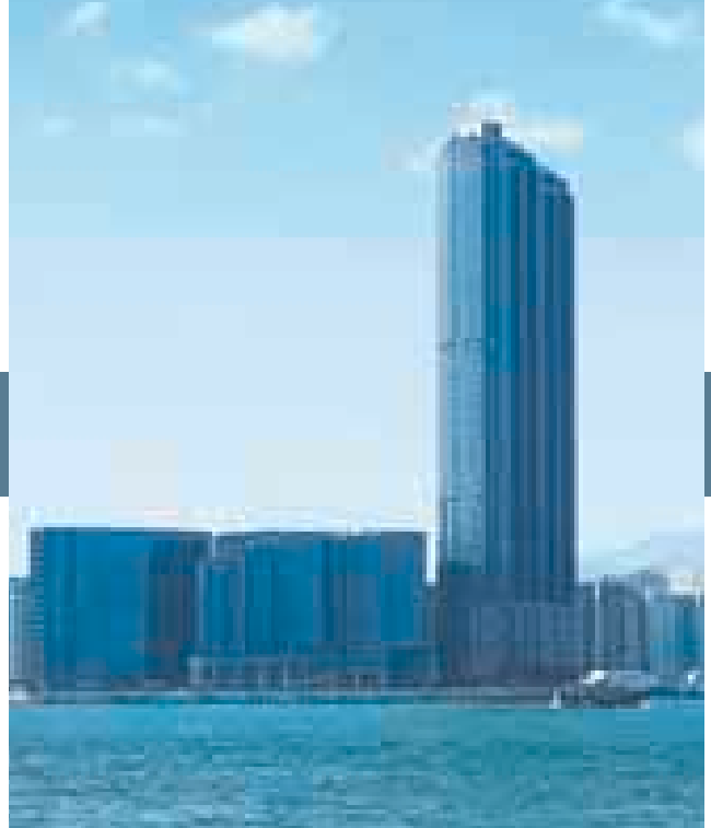
位於紅磡海旁之海名軒樓高七十二層，是香港現時最高的臨海住宅大廈，氣勢非凡。
