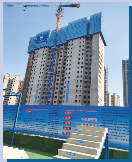
裝配式建築項目施工現場
