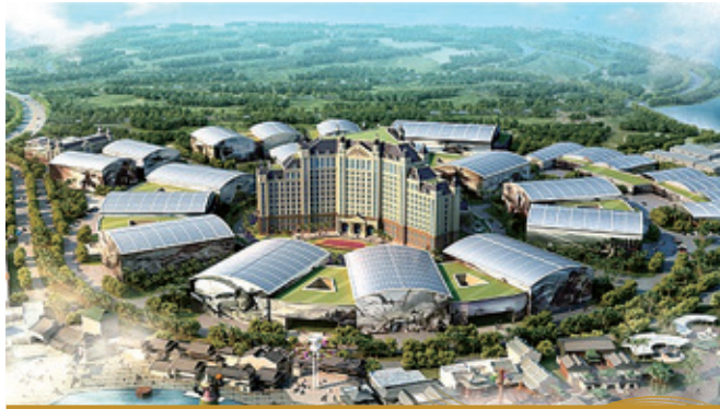
總屋頂光伏面積5.8萬平方米，年發電量達800萬度
