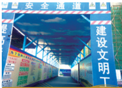
安全通道設置
