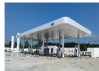
综合能源加注站
