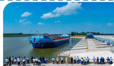
船用LNG储罐及船舶建造
