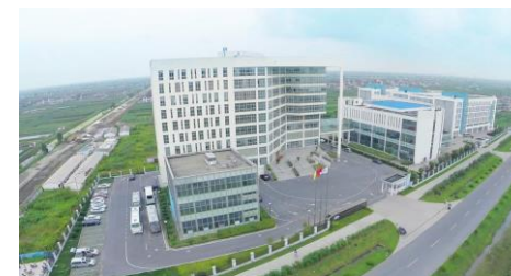
启东 海上氢能事业部
