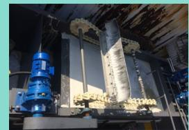
年內南通罐箱對污水處理系統進行改造，將原油漆污水的生化系統與酸洗污水的物化處理系統共用的沉澱池及污泥壓濾系統分開獨立運行，新建處理油漆污水專用的沉澱池，並配備小型污泥脫水機及污泥池，確保經處理後的污水水質達標。
