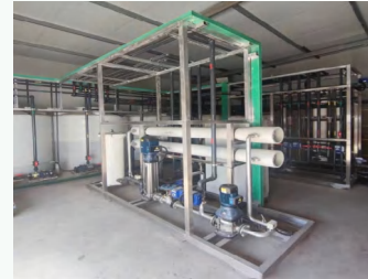
污水站过滤回收装置
