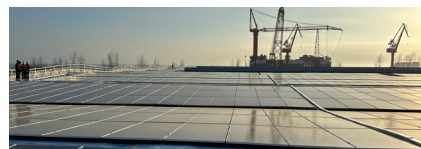
光伏项目实施改善后
