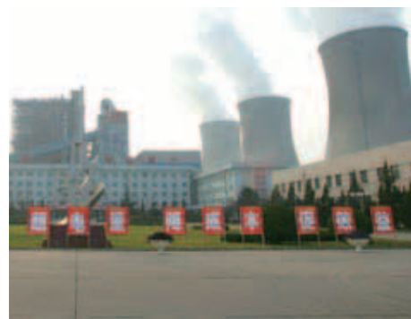
Infrastructure – Shaanxi Weihe Power Co., Ltd
