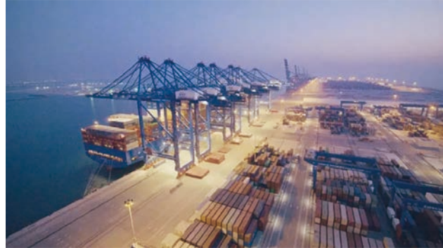
CSP阿布扎比碼頭在設計施工階段積極實施照明節能改造與智能控制，將照明燈具進行節能替換。
