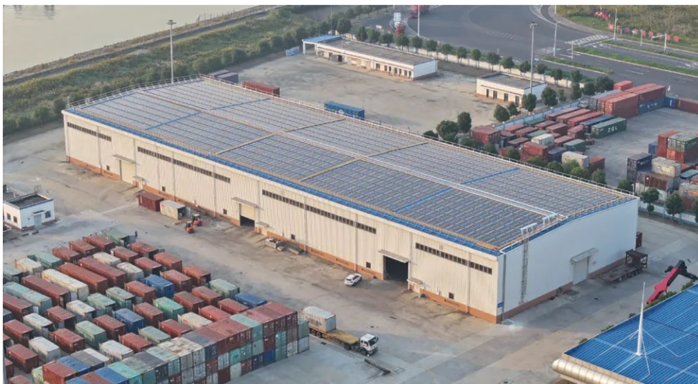
南通通海碼頭分佈式屋頂光伏發電站在2023年11月正式發電，經估算，項目每年可供應清潔能源電力超過170萬千瓦時。
