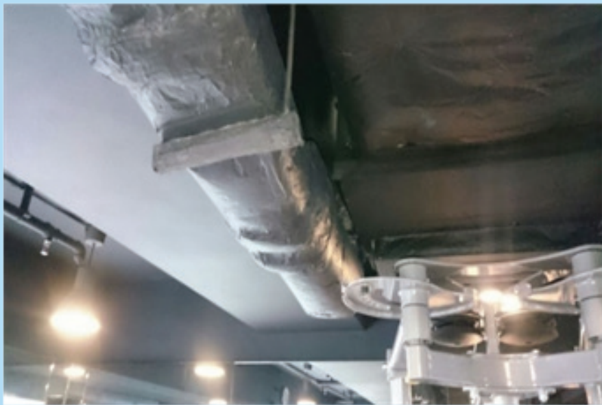
使用防撞物料包裹風槽支架
