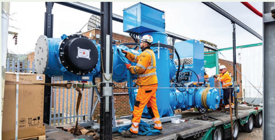
UK Power Networks 的「潔淨空氣」氣體絕緣開關系統。
