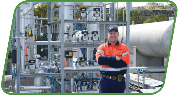
Australian Gas Networks 的 Hydrogen Park South Australia 擁有澳洲營運中最大型的電解槽。
