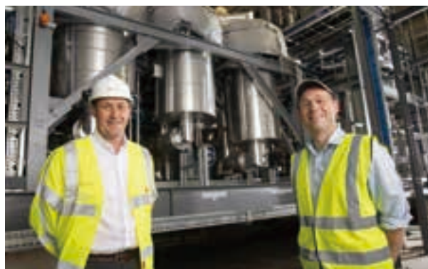
Wales & West Utilities 位於斯溫頓的工廠混合 1% 氫氣
