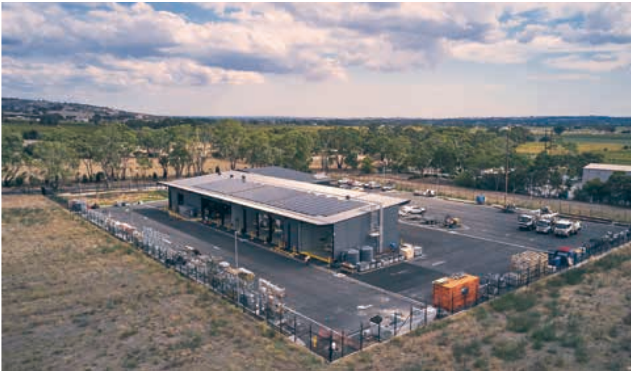
SA Power Networks 的最新倉庫 Angaston 已安裝了 94 千瓦太陽能系統
