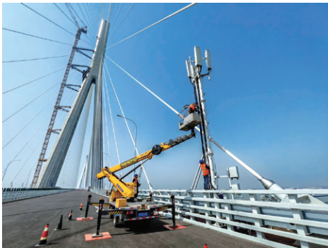
● 工人在大橋最佳位置佈設通信設備
