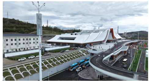
● 瀋白高鐵通信覆蓋建設吉林段
