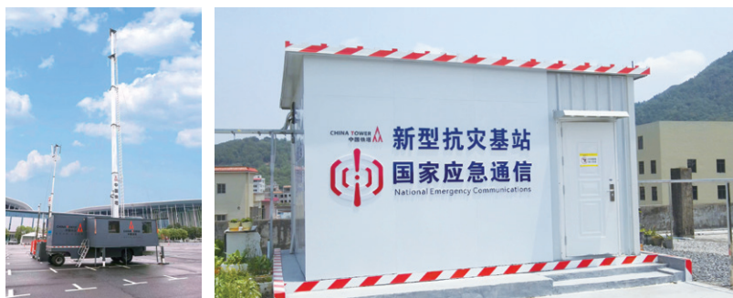
● 移動式超級基站、新型抗災型基站服務應急通信
