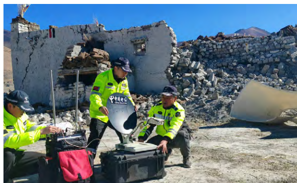
西藏公司应急保障队伍在灾区现场搭建便携卫星基站
