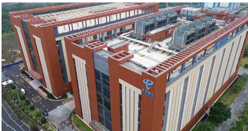
中国电信东盟国际信息园 2 号数据中心
