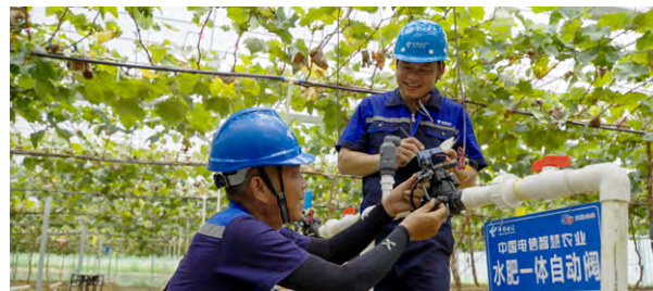
广西公司员工为爱善现代农业庄园安装智能控制设备
