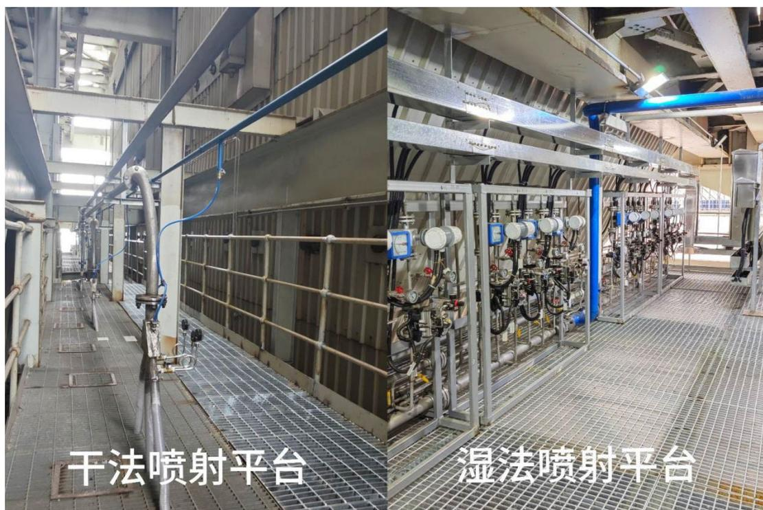
改造期间，该公司采用干湿协同脱除二氧化硫技术路线，运行、检修与厂家联合开展技术交底，提前研判风险、制定预案。试运值守人员全程紧盯参数，快速处置调试问题，优化控制逻辑，高效完成干、湿法脱除装置投运调试，保障改造全流程安全可控、高效推进。改造完成后，机组氮氧化物及二氧化硫排放小时均值直降 50%，为机组清洁高效运行奠定了坚实基础。
