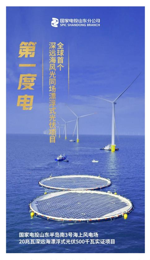
該項目位於山東省海陽市南側海域,離岸 30 公里,水深 30 米。本次建設的 500 千瓦漂浮式海上光伏由兩個環形浮體單元組成,單個浮體單元裝機容量 250 千瓦,由環形抗風浪浮體、耐海洋環境的高強薄膜、光伏系統等組成。在直徑
