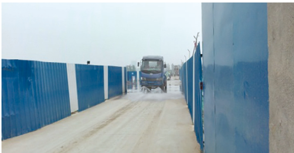
施工场地围挡封闭并喷水抑制扬尘
