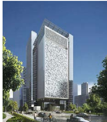
● 前海某人工智能算力中心 (EPC)項目
