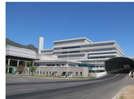
海淀区再生能源发电厂园区
