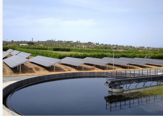
北控水务葡萄牙公司光伏项目
