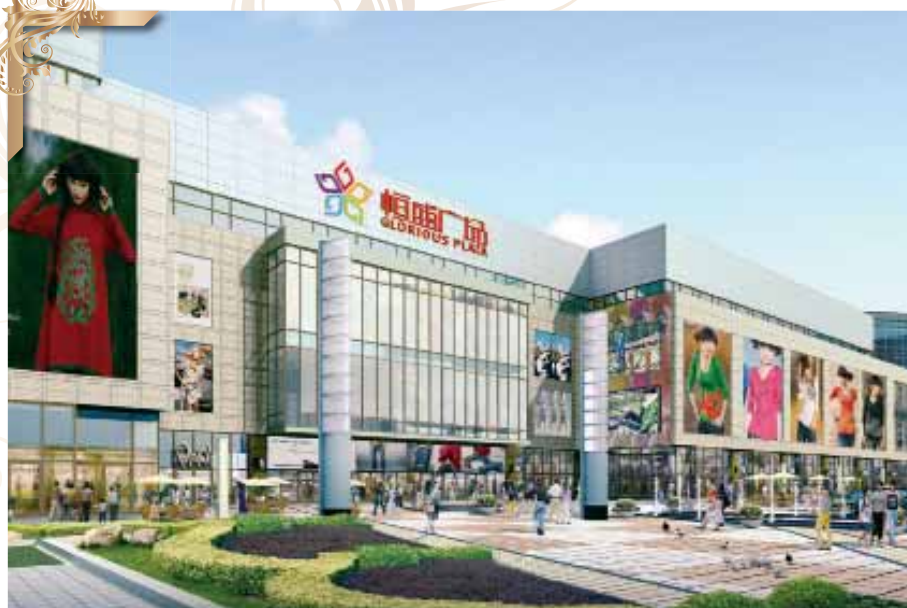
位於瀋陽，仍在建設中的的瀋陽·恒盛廣場
