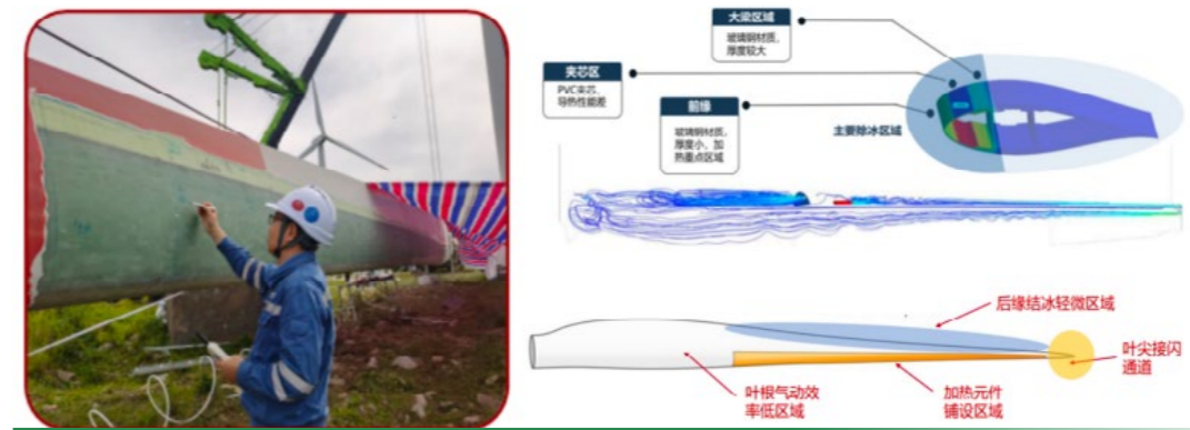
中電華創風電葉片防覆冰塗層技術應用現場 (左) 及技術示意 (右)
