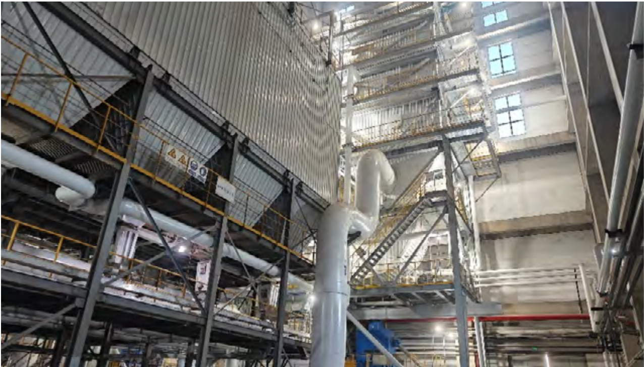
霸州環保煙氣淨化提標改造工程
