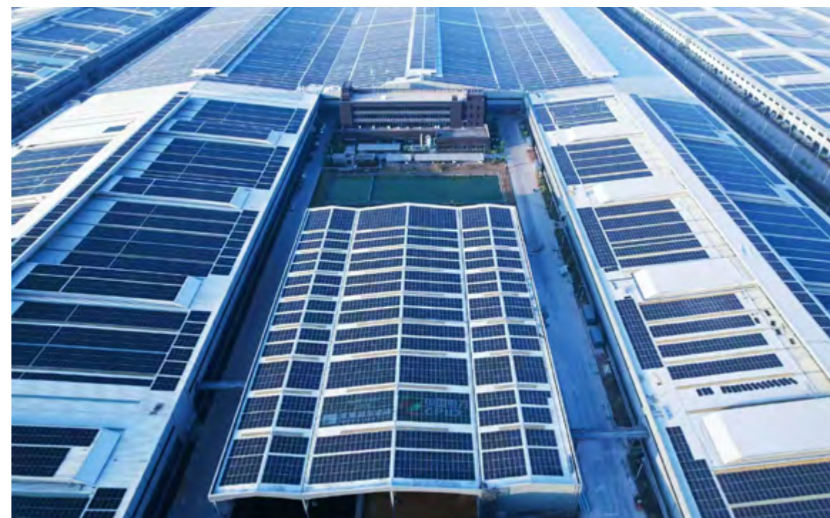
廣西藤縣蒙娜麗莎 85 兆瓦綜合智慧能源項目
