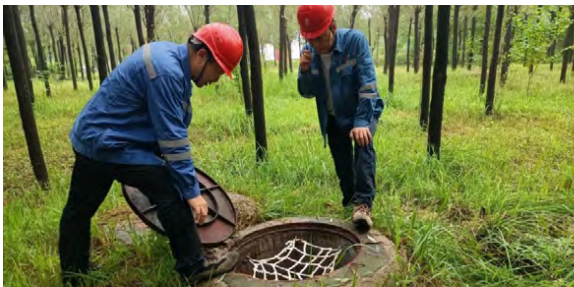
商丘熱電現場檢查
