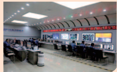
商丘電廠集控室、機組安全穩定運行
