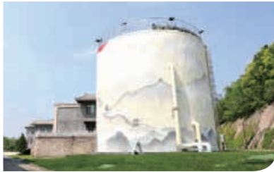
寶之谷綜合智慧能源示範項目
