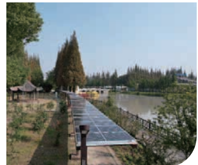
中電長興蔣巷村綜合智慧能源項目
