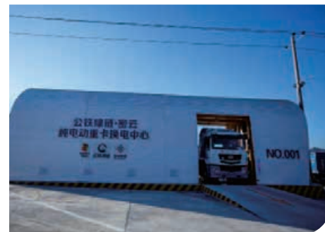
電動重卡換電站
