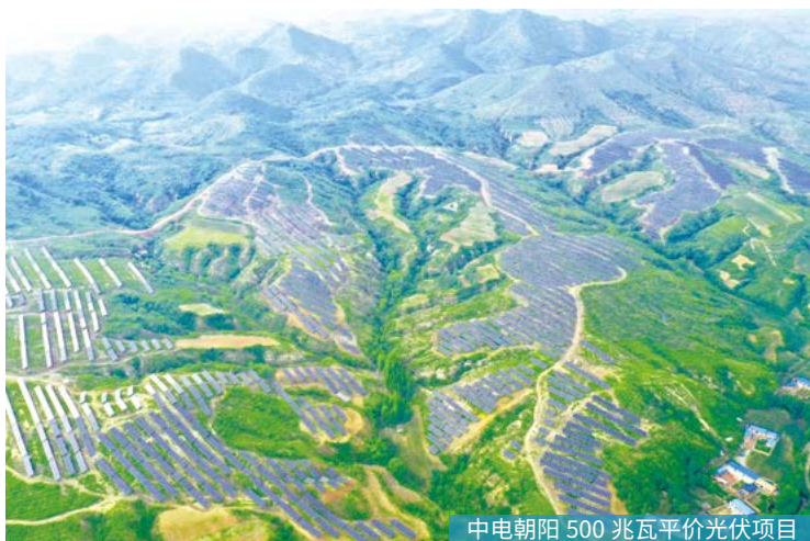
中电朝阳 500 兆瓦平价光伏项目
