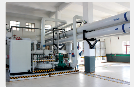
• 姚孟电厂职工生活区供水升压站投入运行
