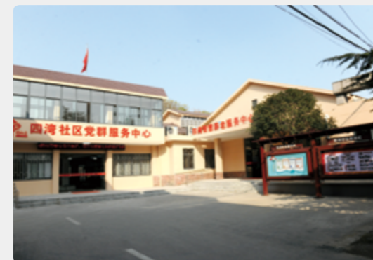
● 燕湖電廠職工生活區完善社區服務功能
