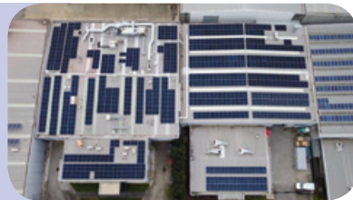
○ 澳優澳洲廠房已於二零二一年九月裝設太陽能板系統。
